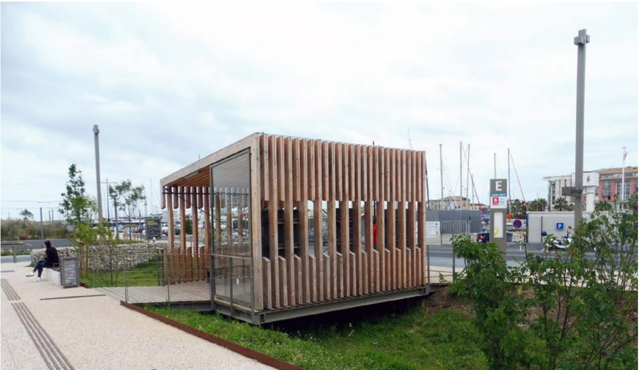
Vue d'un Abri bus
