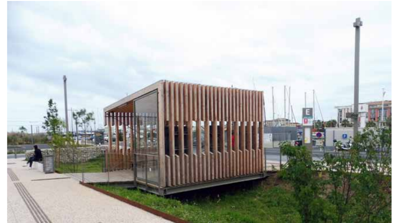
Vue d'un Abrisbus
